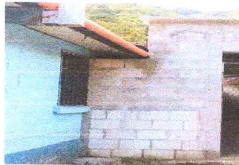
Foto 6: Sustitucion de canales se encuentra en mal estado.
