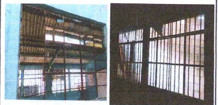
Foto 5: Sustitucion de ventanas de estructura de metal con vidrio de 5mm de 2.00 mts x 1.10 mts
